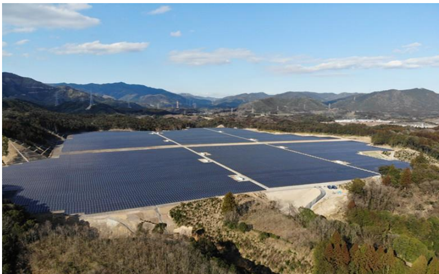
25 MW Solaranlage in Miyazaki (Quelle: Toshiba)
